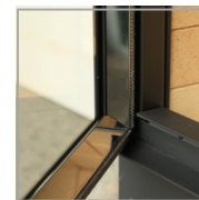
rama drzwi od wewnątrz wykończona stalą nierdzewną
