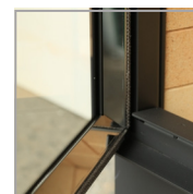
rama drzwi od wewnątrz wykończona stalą nierdzewną
