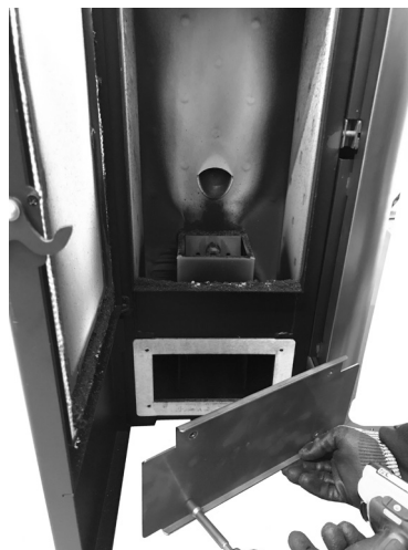
Fig. 31 - Usunąć zamknięcie rewizyjne.
