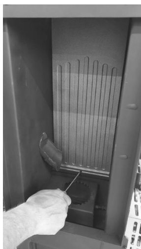
Rys. 56 - Demontaż tylnej części paleniska 1
