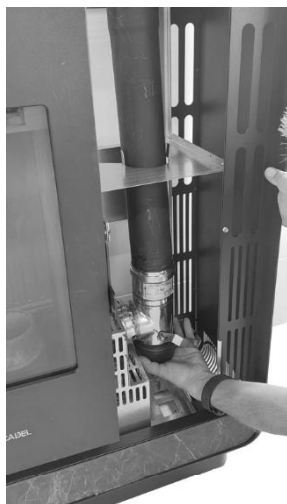
Rys. 54 - Czyszczenie kanału dymowego
