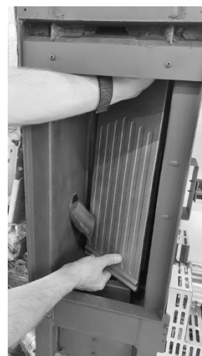
Rys. 57 - Demontaż tylnej części paleniska 2
