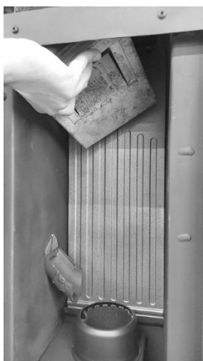
Rys. 55 - Demontaż głowicy paleniska 1
