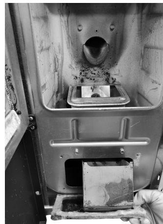
Fig. 68 - Usunąć zamknięcie rewizyjne.
