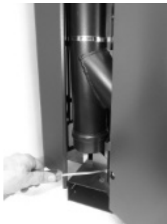
Fig. 65 - Wykręcić blokadę korka.
