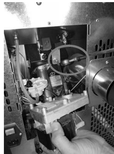
Fig. 46 - Usuwanie motoreduktora
