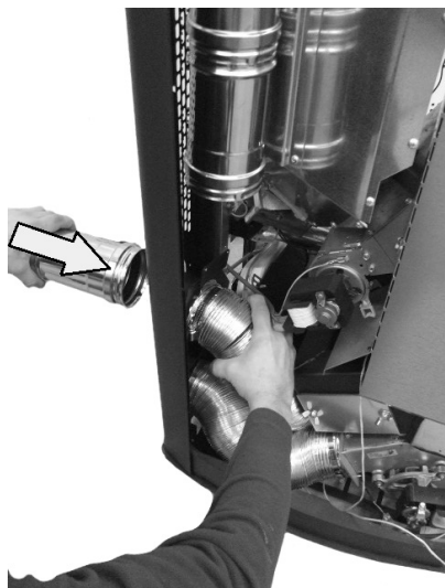
Fig. 66 - Układanie rur układu kanałowego
