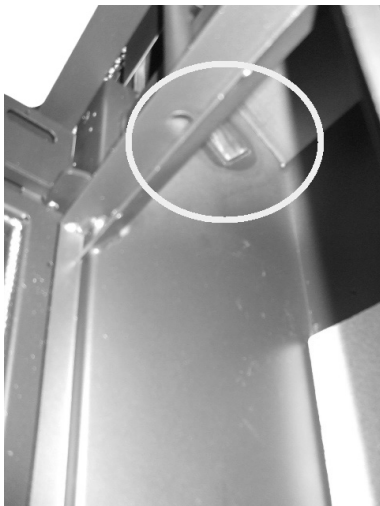
Fig. 96 - Przejście spalin
