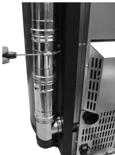
Fig. 103 - Czopuch (Sfera³ Plus, Sfera³, Globe, Elise³ Plus)
