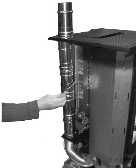
Fig. 56 - Układanie rur do górnego układu kanałowego
