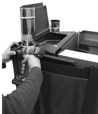
Fig. 47 - Ponowne umieszczanie górnych zakrzywionych profili
