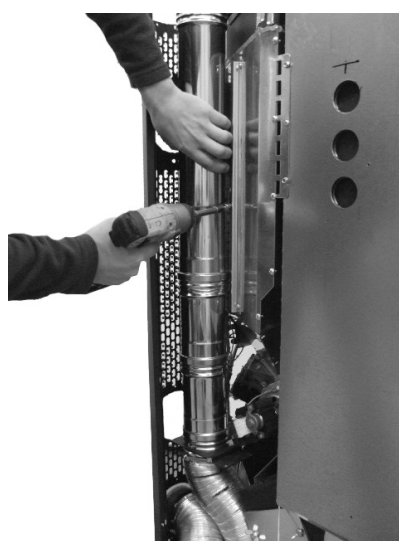
Fig. 64 - Mocowanie rury
