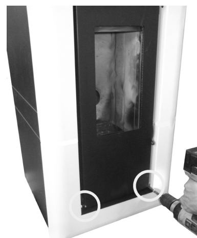
Fig. 32 - Mocowanie ramy
