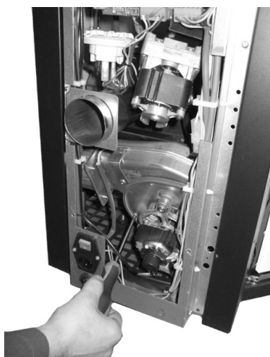
Fig. 104 - Czyszczenie odciągu dymu: faza 1
