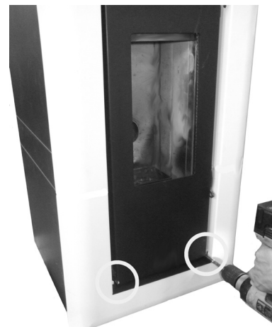
Fig. 26 - Mocowanie ramy
