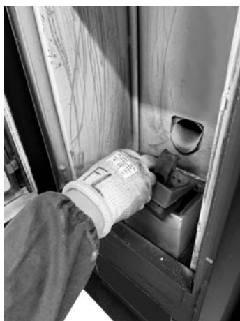
Fig. 21 - Wyjmowanie rusztu paleniskowego
