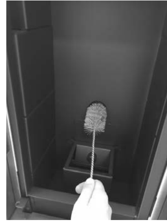
Fig. 24 - Czyszczenie szczotką do rur
