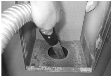
Fig. 27 - Czyszczenie komory rusztu paleniskowego
