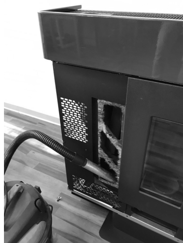
Fig. 33 - Czyszczenie komory spalin
