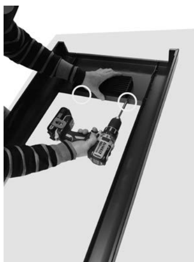
Fig. 12 - Mocowanie kratki
