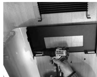
Fig. 19 - Przymocowanie panelu do słupka
