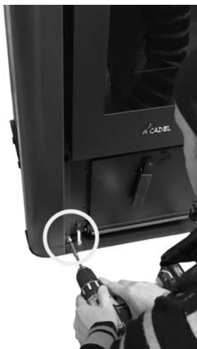
Fig. 14 - Mocowanie ramy
