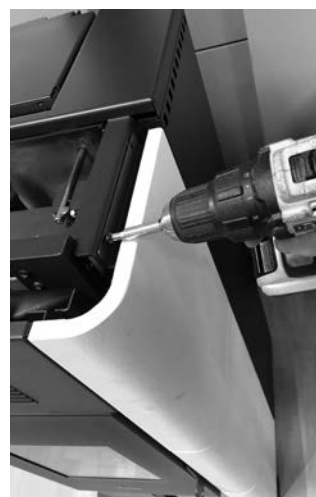
Fig. 27 - Mocowanie do panelu
