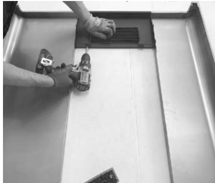
Fig. 32 - Mocowanie kratki
