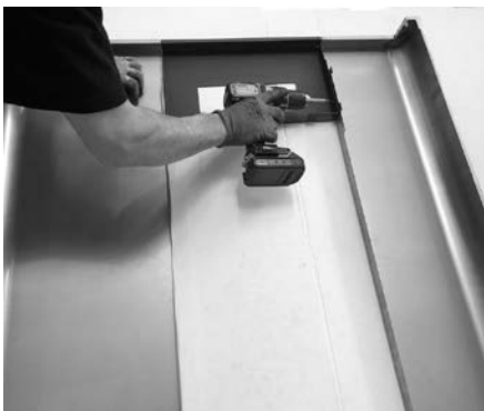
Fig. 31 - Mocowanie słupka
